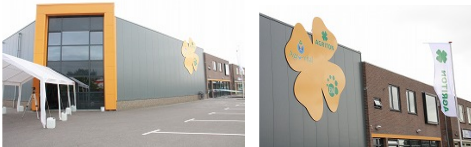
Het nieuwe gebouw van Agriton
